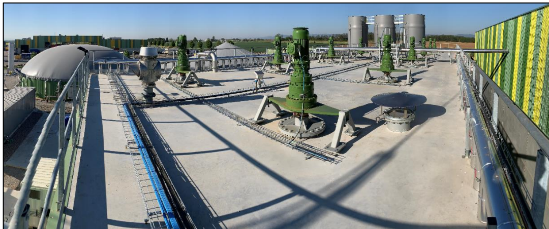
Illustration n° 6 : Vue sur le toit du digesteur et les moteurs des agitateurs
