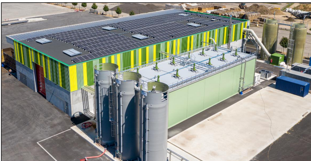
Illustration n° 5 : Vue sur le digesteur
