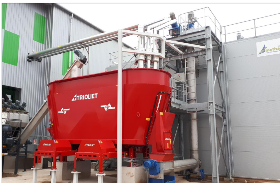
Illustration n° 4 : Bol mélangeur et vis de gavage
