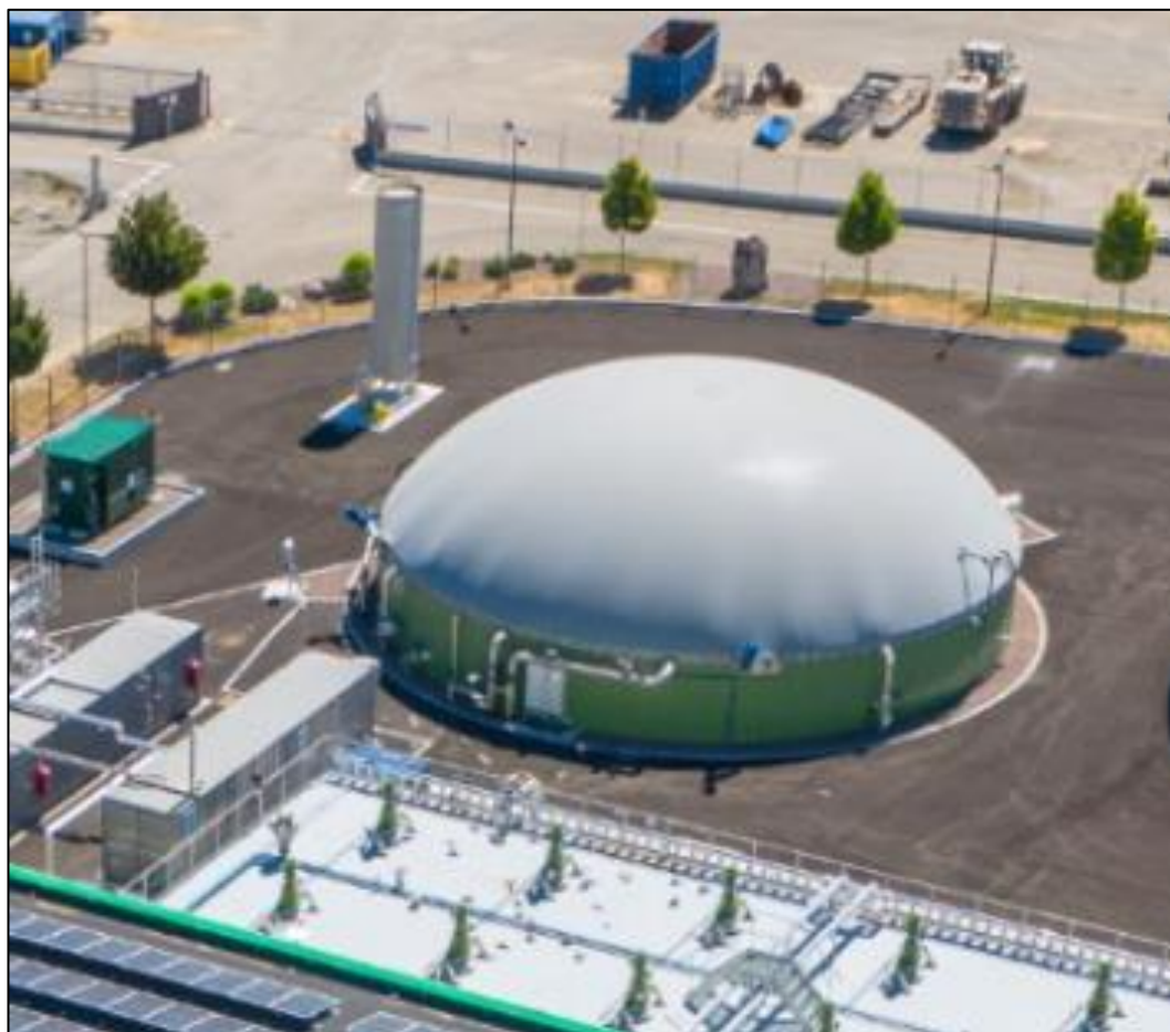
Illustration n° 9 : Vue sur un stockage de digestat liquide avec gazomètre
